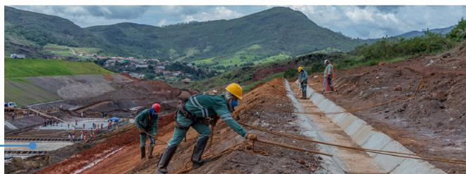
**Barragem Doutor, da Mina Timbopeba (Ouro Preto):** construção do novo vertedouro em andamento, previsão de término desta primeira etapa no final de 2021.
