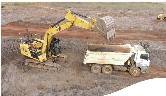
As atividades para a **eliminação da barragem Sul Superior** avançam com sucesso. Desde abril, já foram concluídos o bombeamento do lago do reservatório e a instalação de instrumentação complementar com equipamento remoto.
