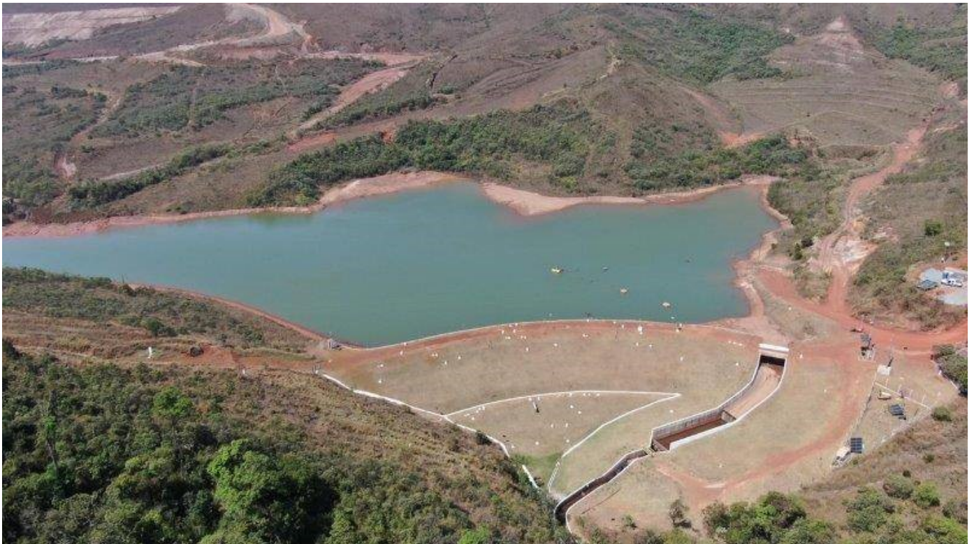
Barragem Marés II é uma das quatro estruturas que obteve DCE positiva
