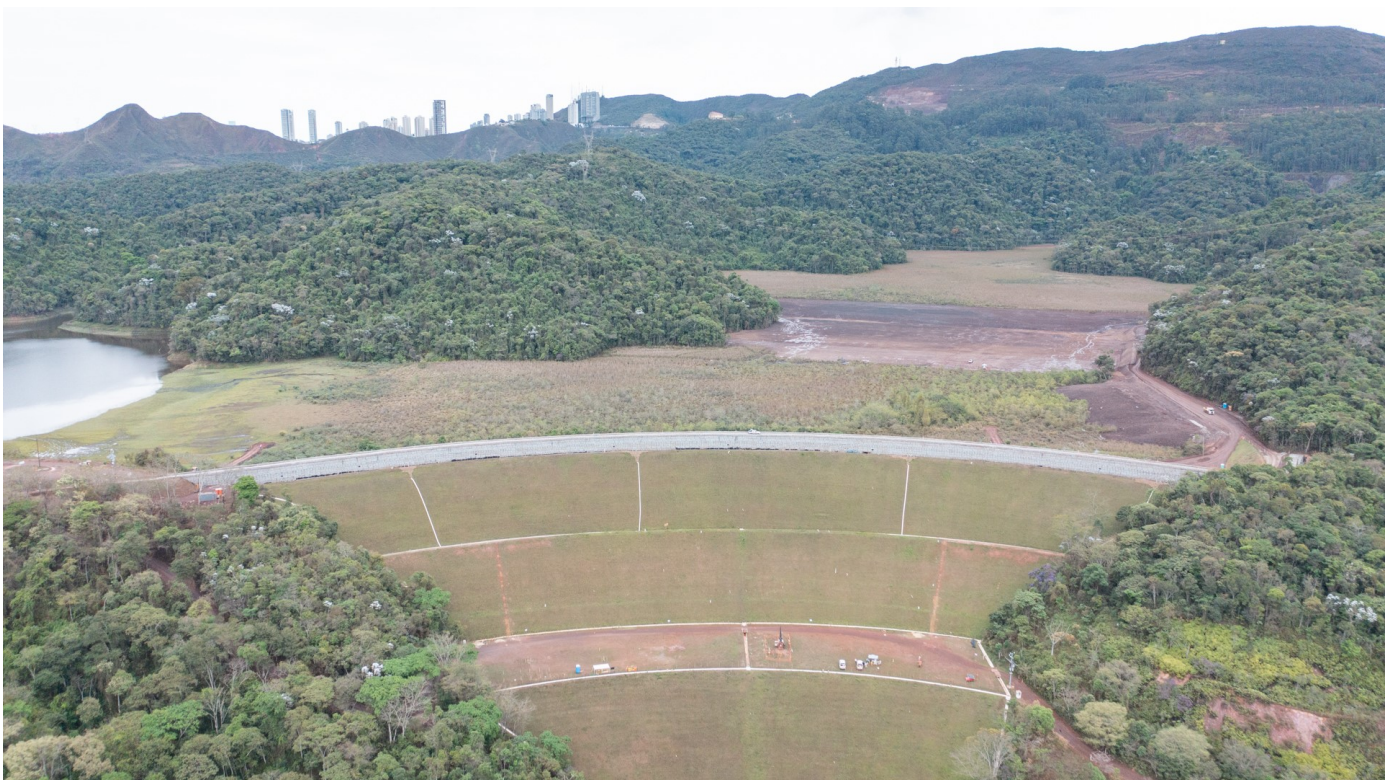
Barragem B5/MAC teve seu dique interno a montante eliminado e as condições de segurança e estabilidade atestadas
