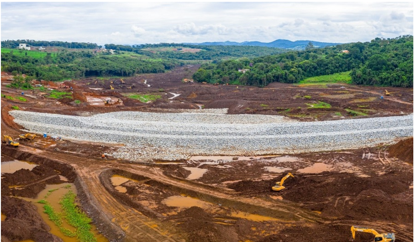
Maciço de uma das barreiras hidráulicas implantadas para conter o rejeito
