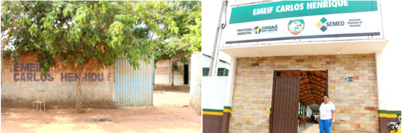
Escola Municipal Carlos Henrique, em Canaã dos Carajás, antes e depois da reforma
