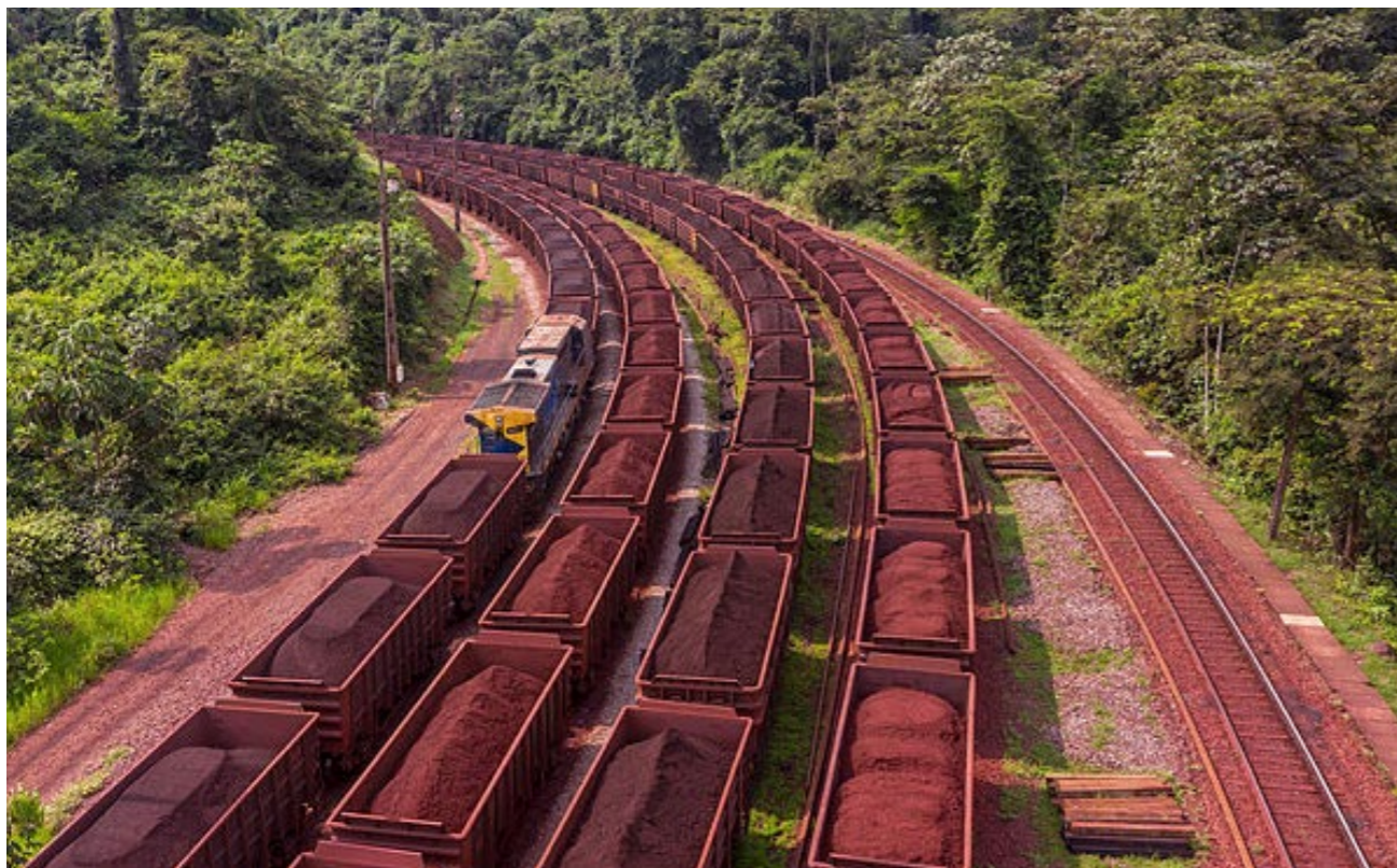
Estrada de Ferro Vitória a Minas (EFVM)
