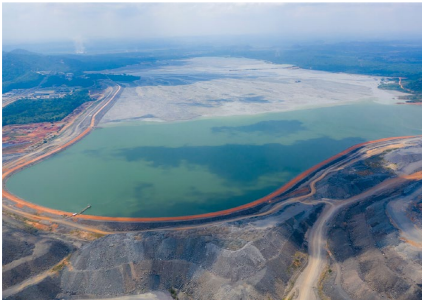
Canaã dos Carajás, Pará, Brasil, 03/12/2020 – foto aérea, com drone, da barragem da mina do Sossego Foto: Ricardo Teles
