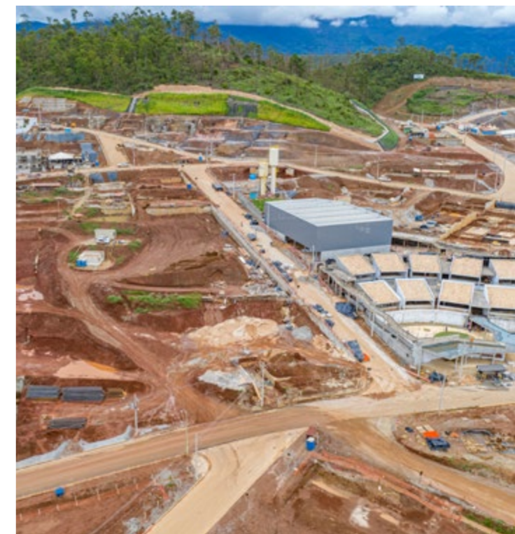
Obras do reassentamento de Bento Rodrigues, em Mariana (MG). Foto: Guilherme Guedes
