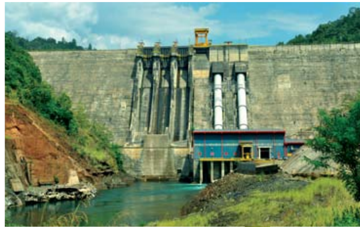
Bendungan Balambano Balambano dam
