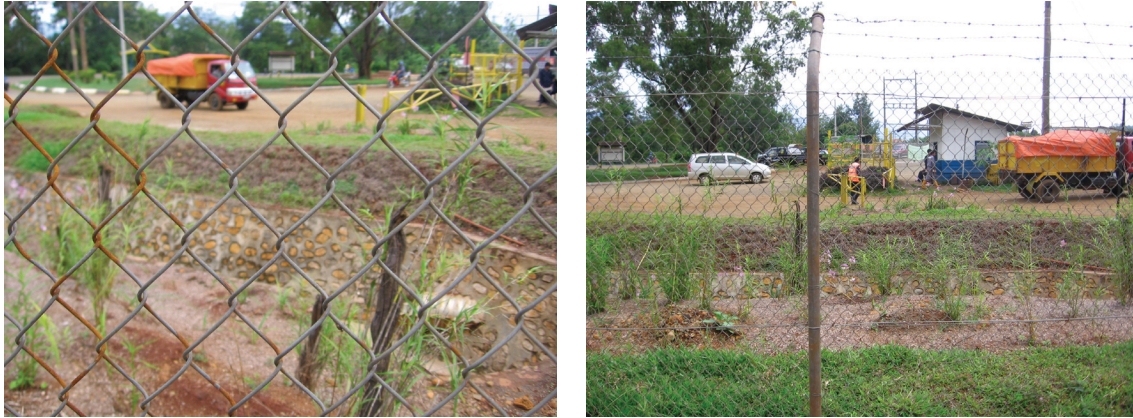
Gambar 25. Bentuk kawat harmonika yang layak dipergunakan sebagai pagar luar dan partisi pagar dalam (foto: G. Semiadi).
