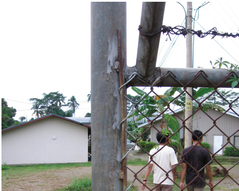
Gambar 26. Penguatan tepian pagar kawat harmonika dengan pengelasan meggunakan plat besi (foto: G. Semiadi).
