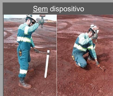
Sem dispositivo Atividade de punção de pino e locação de estaca com 02 suportes separados
