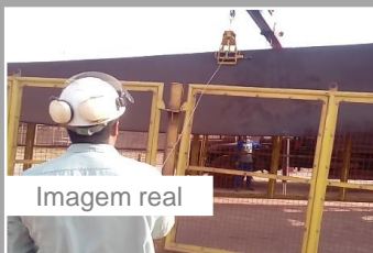
Operação da nova tenaz
