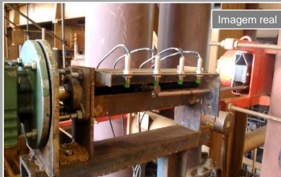
Calibrador automático acoplado ao densímetro radioativo em operação
