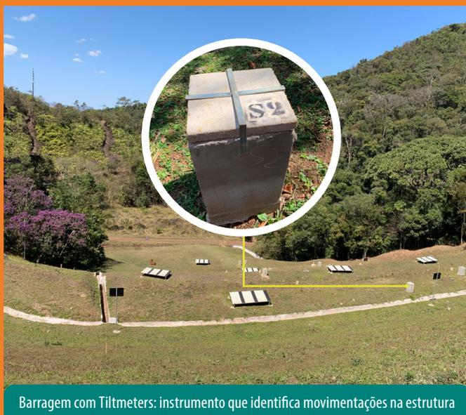
Barragem com Tiltmeters: instrumento que identifica movimentações na estrutura
