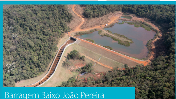
Dique auxiliar da barragem B5
