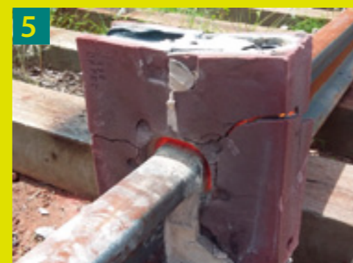
5 Solda rebarbada em processo de resfriamento
