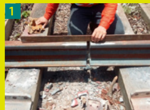
1 Alinhamento dos trilhos para soldagem
