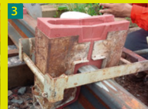
3 Molde travado e pronto para ser calafetado
