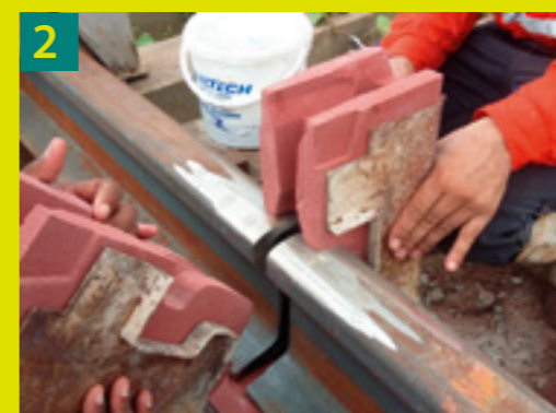
2 Montagem do molde na região da solda
