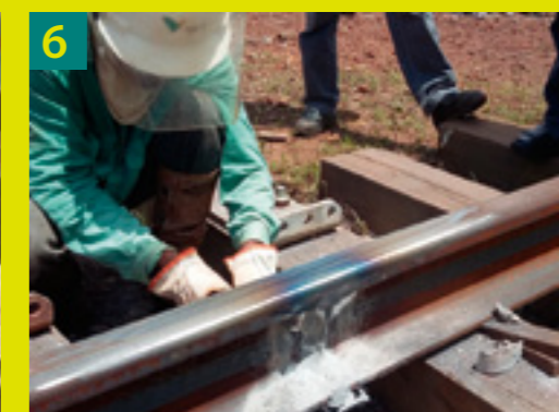
6 Inspeção visual da solda já acabada
