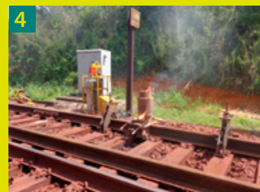
4 Reação aluminotérmica e vazamento da solda
